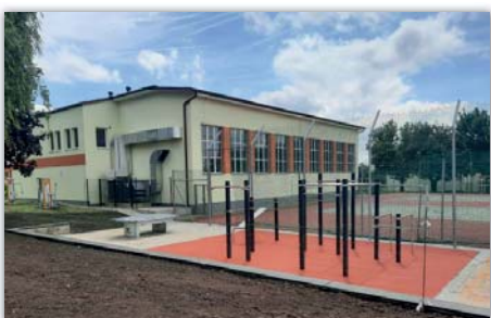
Pingpongový stůl, workoutové stroje a prvky – už se rýsuje nové sportoviště u školy
