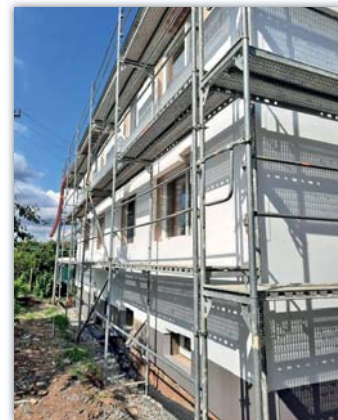
Zateplení bytového domu za školou
