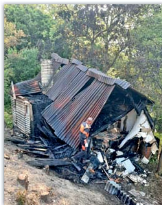
Následky požáru jedné z chatek
