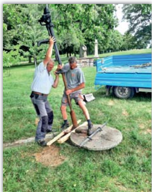
Oprava pumpy na Antonínku
