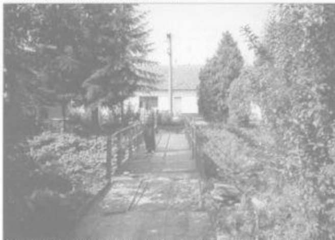
Zrekonstruovaná lávka za kulturním domem. Zatěžkávací zkouška provádí Miroslav Lukát.
