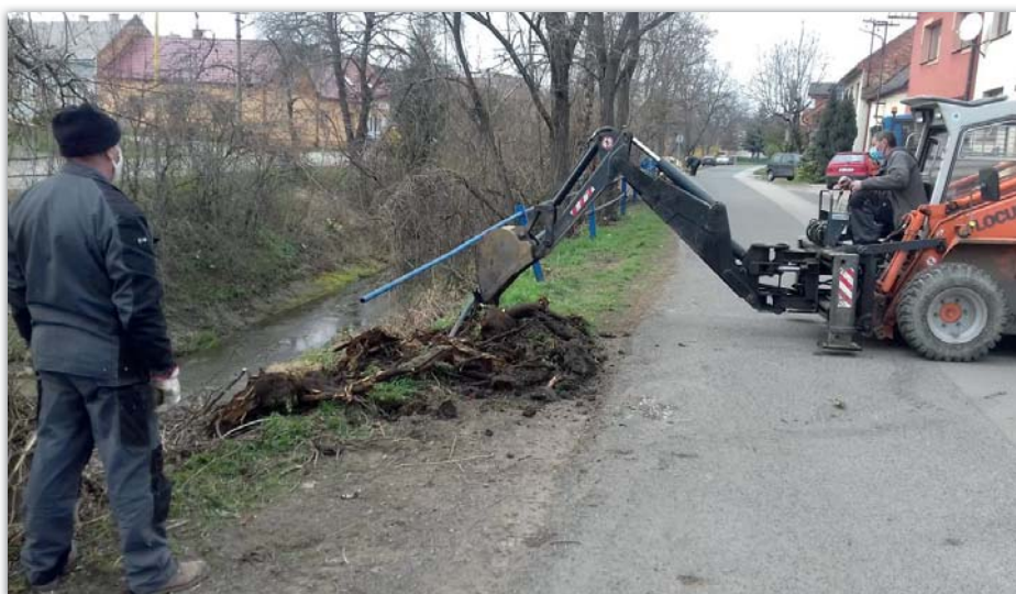
Oprava zábradlí na Řádku.
