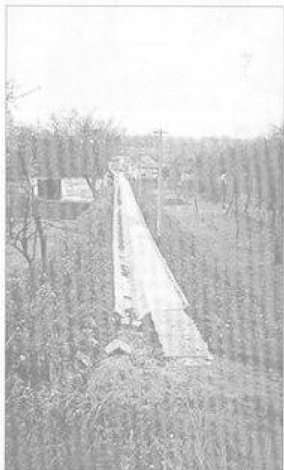
Ulička Řádek – Staré Hory po rekonstrukci
