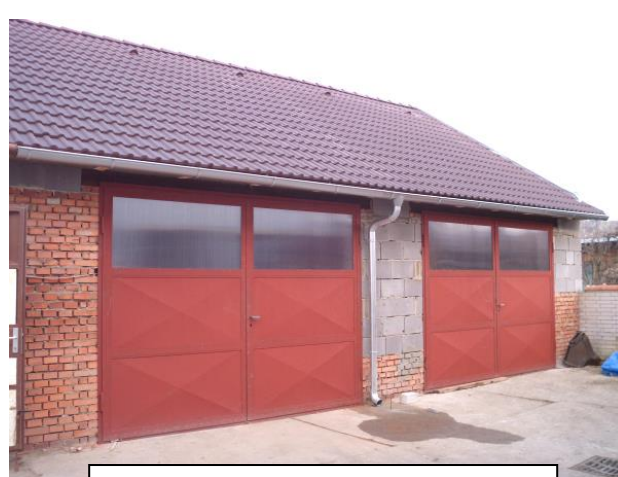
Výstavba garáže a dílny ve dvoře obecního úřadu
