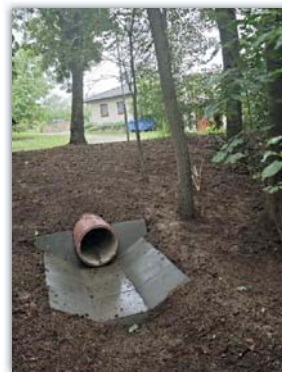
Vyústění odtokového žlabu na dešťovou vodu z Roháčů
