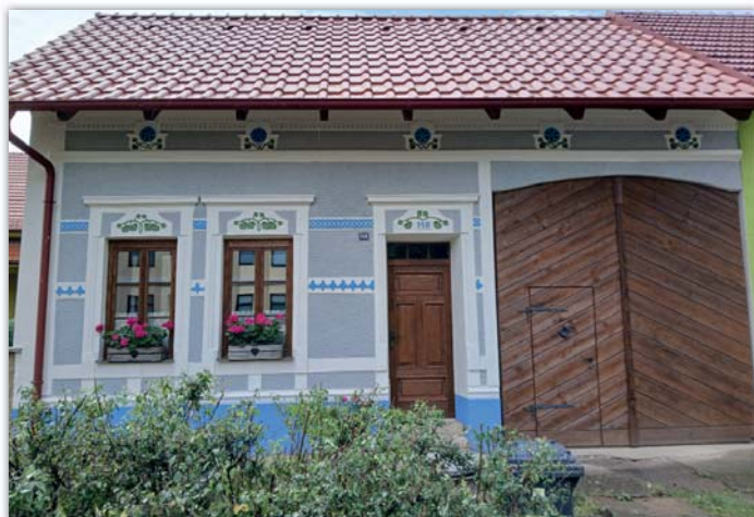
Rekonstrukce domu na Náměstí se vydařila po všech stránkách
