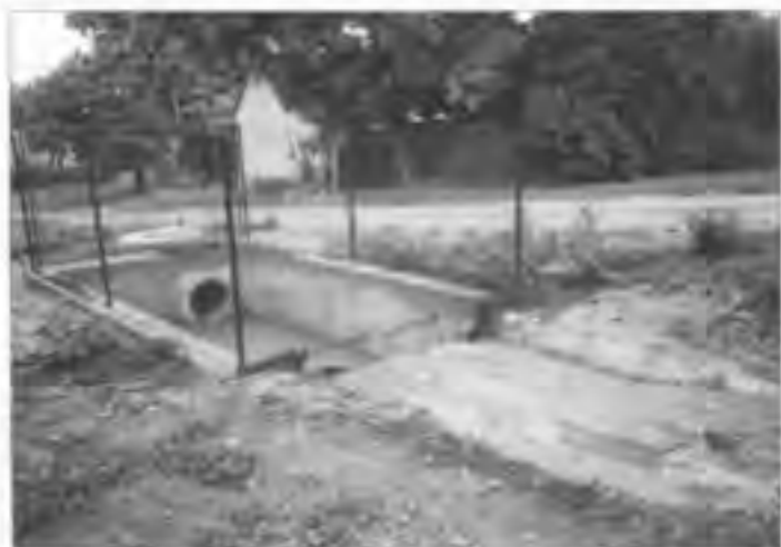
Záchytný objekt na Robkově boudě naplněný naplaveninou
