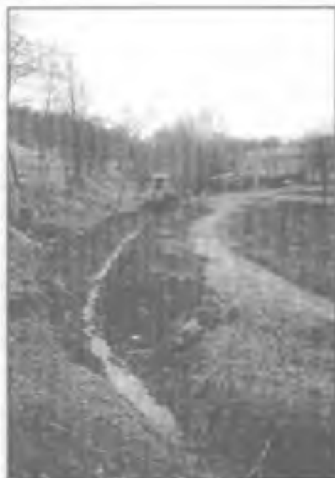
Prohloubení koryta járku
