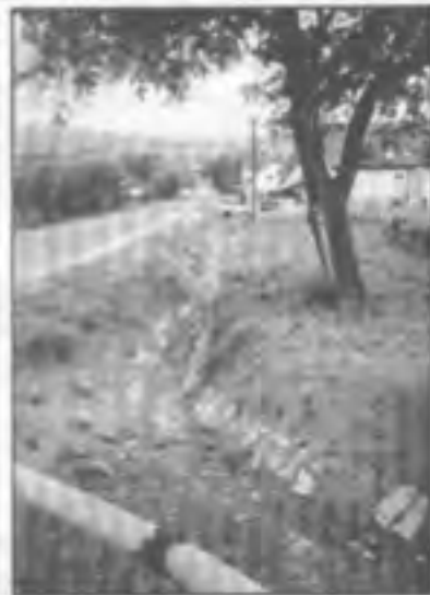
Čištění příkopu k Antonínku
