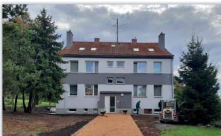
Opravený bytový dům č.p. 709 za školou
