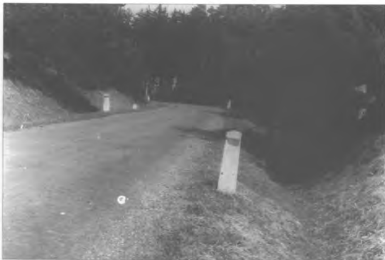
Zatáčka při vjezdu do lesa v roce 1961. Za posilovací stojí čistota příkopu což dnes není již pravidlo
