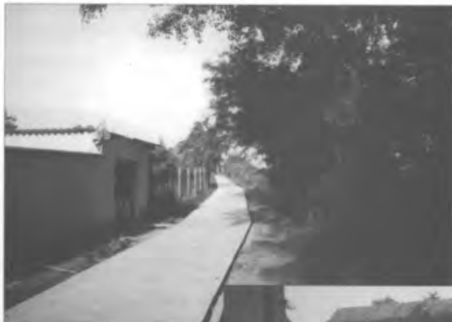
Celkový pohled na chodník od Heskového
