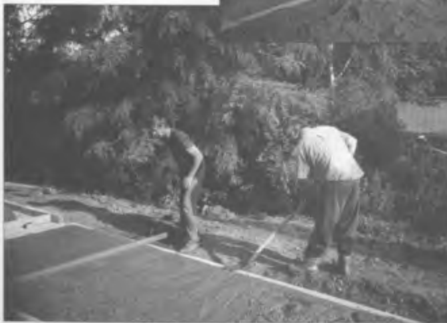
Lubomír Ivan a Ladislav Míšek také při stávkování betonu
