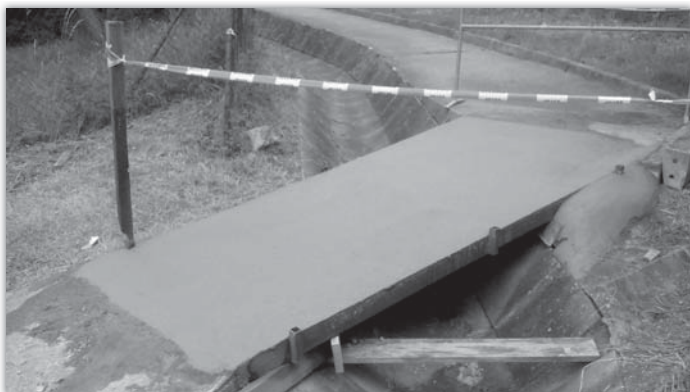
Vybetonování nového mostku v uličce pod Starýma horama. Dnes už je zde samozřejmě také nové natřené zábradlí.
